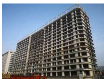
主体封顶时的综合楼
