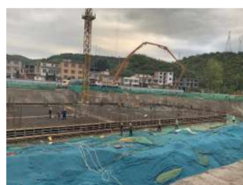
基础施工现场
